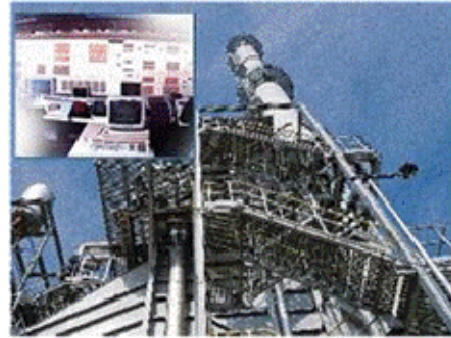
(b) Central térmica
