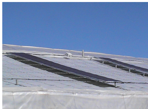
Figura. Detalle de instalación de los paneles fotovoltaicos del tratamiento T1.
