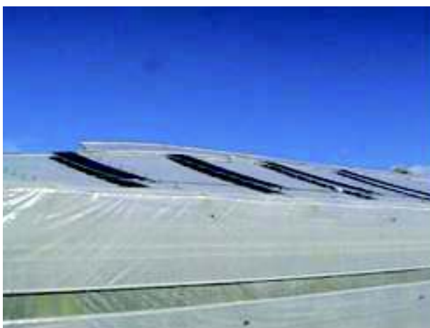
Figura. Detalle de instalación de los paneles fotovoltaicos.
